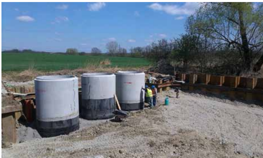
Stavba čistírny odpadních vod.
