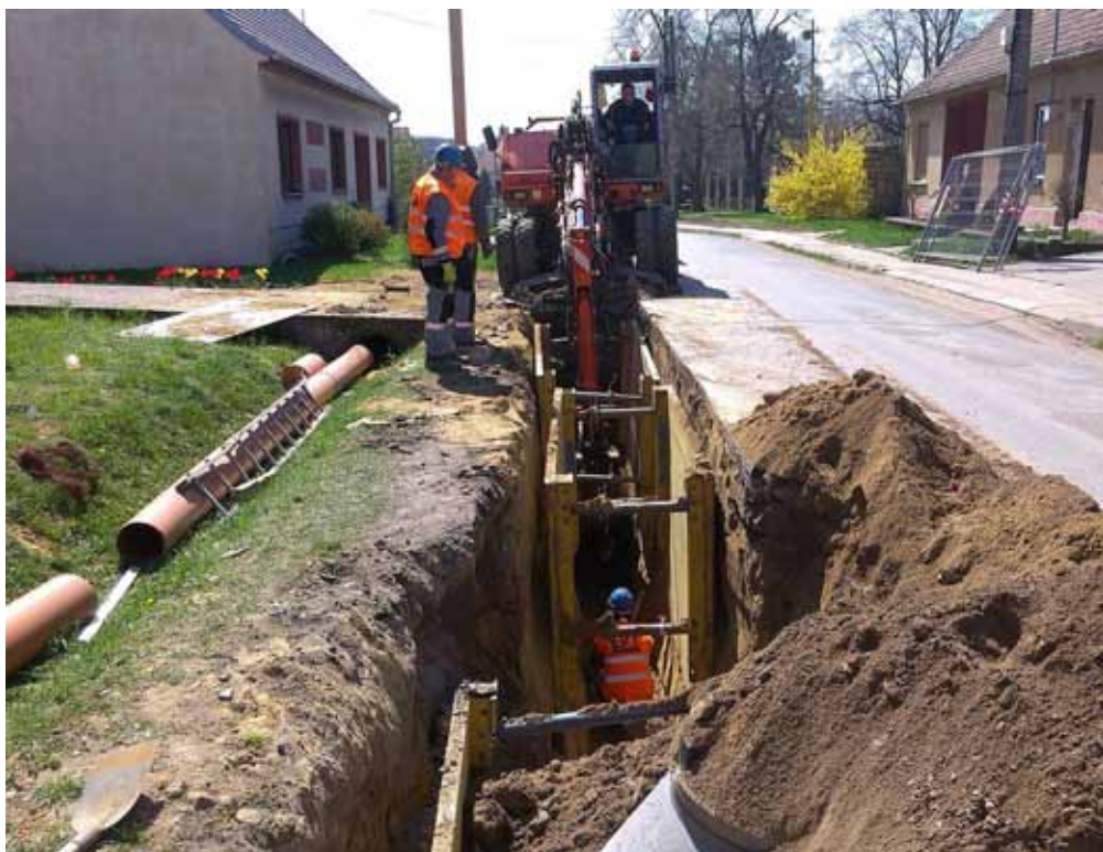
Výstavba splaškové kanalizace v obci.
