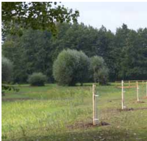
dokončená stavba včetně výsadby stromů, říjen 2015
