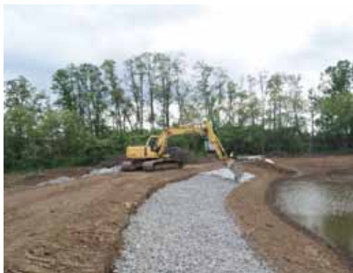
budování kamenné hráze, 27. 5. 2015
