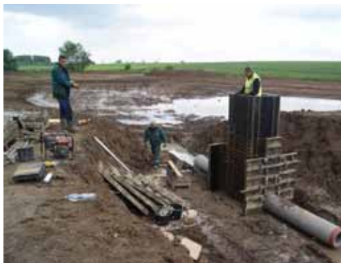
práce na stavidle, 27. 5. 2015
