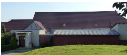
Fotodokumentace rekonstrukce mateřské školy 2019 - 2020.
