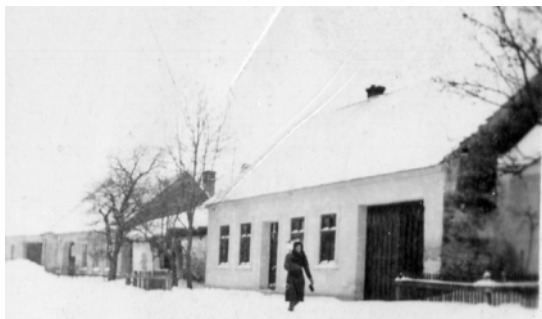
Zleva dům čp. 44, 43, 42, 99 a část dnes již neexistujícího domu čp. 41
