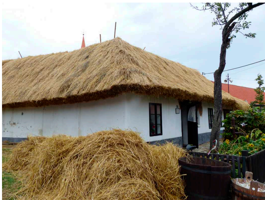
Na podzim 2024 se po 20 letech vyměnila krytina na venkovské usedlosti čp. 10. Doškařskou práci provedla firma Františka Pavlici z Hroznové Lhoty.
